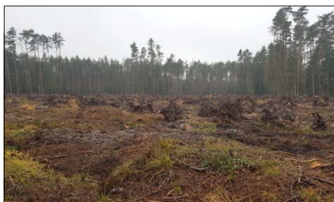
Powierzchnia w trakcie porządkowania
